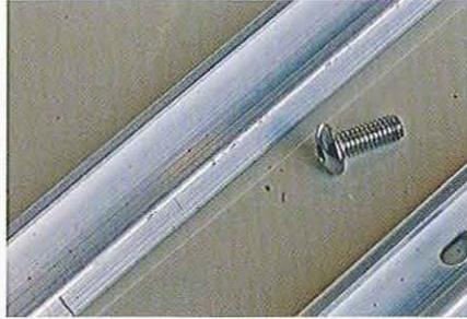
07.18 La baguette porte-caoutchouc peut être fixée en place par des boulons à tête ronde basse qui n'interlèveront pas avec la moulure en caoutchouc.
