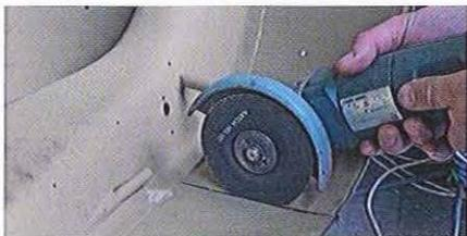
04.12 Coupez la tôle avec une meuleuse d'angle équipée d'un disque "plasma", trois fois moins épais que les disques traditionnels et capable d'effectuer une coupe de précision. L'inconvénient est qu'ils sont si minces qu'il ne tolèrent aucune contrainte latérale sans éclater. Prenez toutes les précautions possibles.
