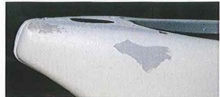
05.14 Le stopper s'utilise en couche très fine, avec un applicateur spécial ou plus simplement avec le bout du doigt (bien dégraissé) ou une cale souple (bien dégraissée) ou une cale souple. L'air contenu dans le stopper s'échappe et le produit se rétracte en séchant : il faut donc en mettre plus que prévu et attendre vingt-quatre heures avant de poncer, sinon le produit sera entraîné par le papier abrasif.
